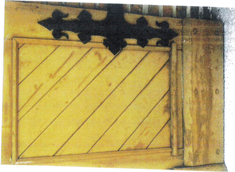
Fot. 15 Kościół parafialny p.w. . Matki Boskiej Różańcowej w Smardzowicach. Rok 2023, stan istniejący obiektu, przed konserwacją. Elew. boczna, płd, widok skrzydeł drzwi zawiasy, wejście od strony do nawy kościoła.
