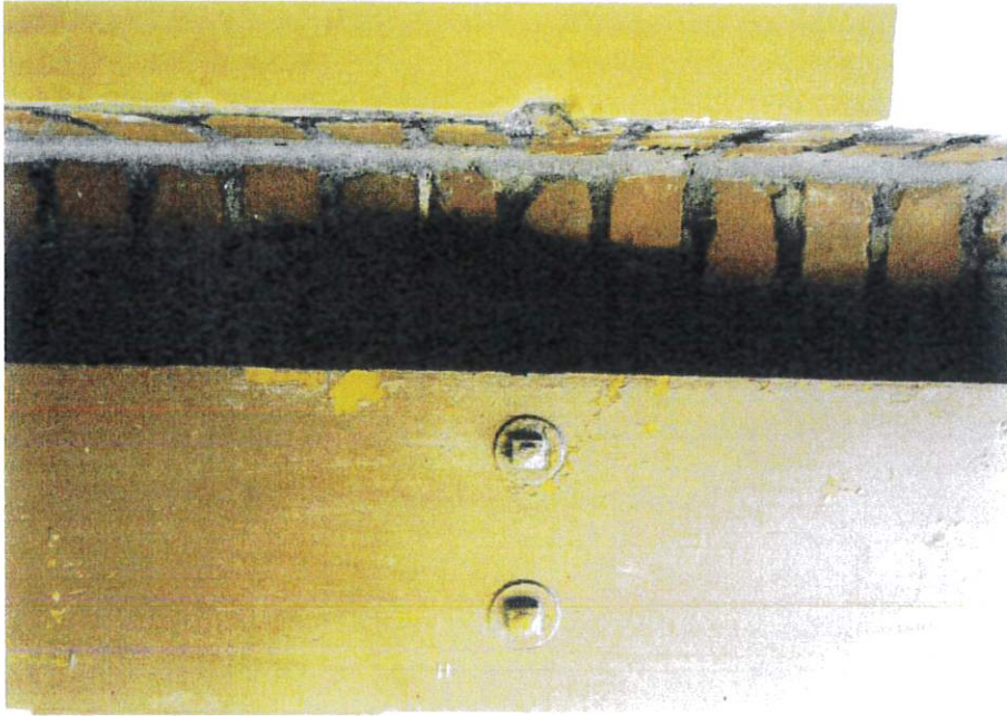
Fot. 21 Kościół parafialny p.w. , Matki Boskiej Różańcowej w Smardzowicach. Rok 2023, stan istniejący obiektu, przed konserwacją. Elew. boczna, płd. fragm. skrzydeł drzwi zawiasy, i wejście od strony do nawy kościoła.
